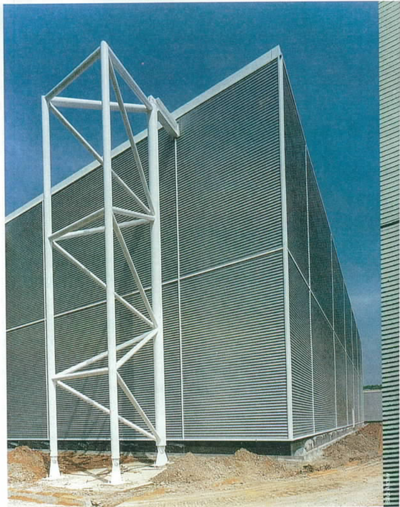
Der Gewerbebau ist ein klassisches Einsatzgebiet für zweischalige Wandaufbauten. Unser Bild zeigt die Verwendung eines Wellprofils. Im ersten Teil dieses Forschungsberichtes (Fassadentechnik 5/2002, Seite 22, Abbildung 5) wurde dieses Wellprofil in der Darstellung des Wandaufbaus durch einen technischen Fehler leider abgeschnitten.
