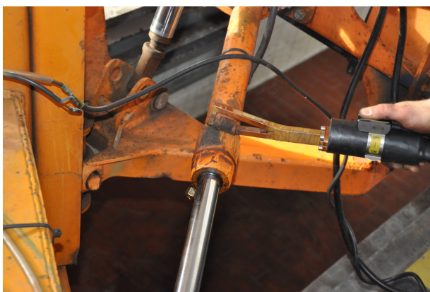
Bild: Die mit Gewindekleber gesicherte Mutter des Zylinders wird durch Erwärmen auf 200°C beschädigungsfrei geöffnet
